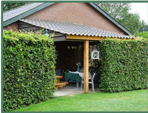
Voorzijde loods met aanbouw
