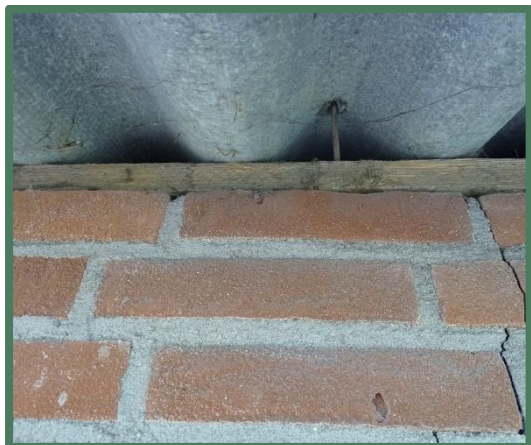
Muurplaat direct op de bakstenen wand
