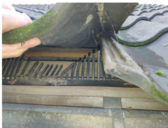
Vogelschroot in het dak van de woonboerderij.
