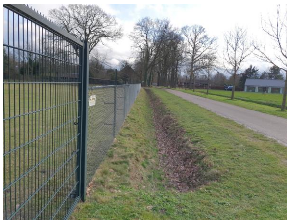
M.u.v. het achterste gedeelte is het gehele terrein afgesloten met hekwerk. Drooggevallen sloot/greppel zichtbaar.
