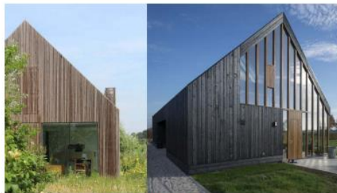
Materialisering ondergeschikt aan het volume
