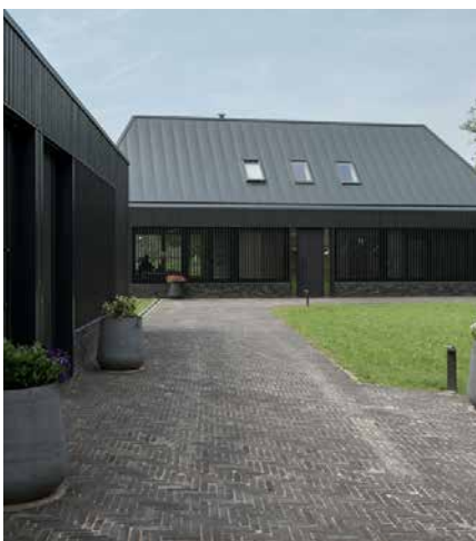
Volumes aan de verharde buitenruimte
