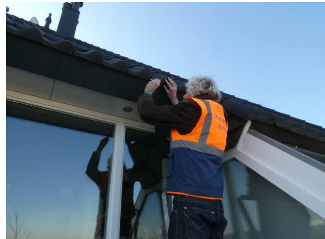
Figuur 11: Inspectie van het dak
