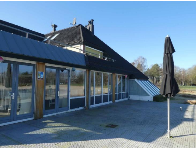
Figuur 10: Zijde van het gebouw waar uitbrieding plaats gaat vinden
