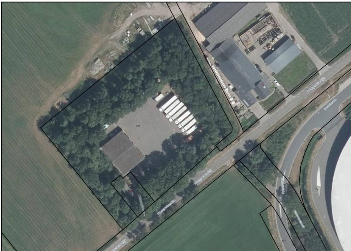
Afbeelding 3: Bestaande situatie plangebied
