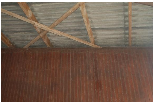
Afbeelding: niet geïsoleerd dak
