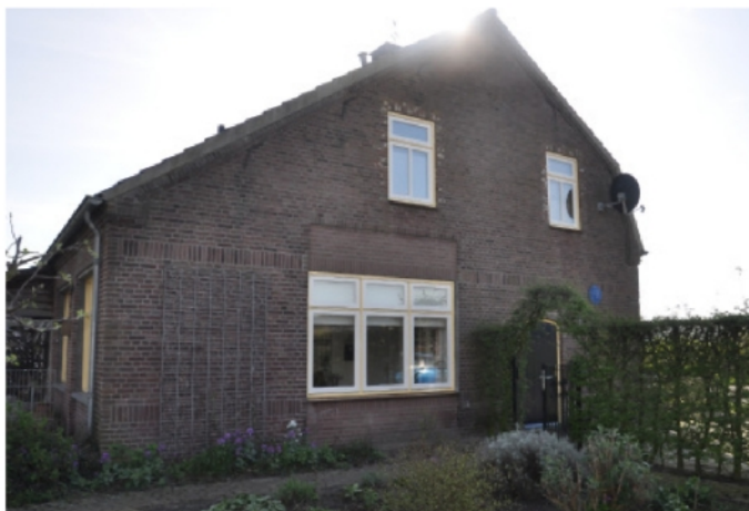
Hierboven de westelijke zijgevel, waarvan een deel bestaat uit de uitbouw van volume B.
