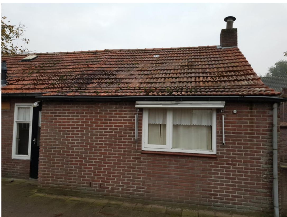
Zijaanzicht te slopen woning
