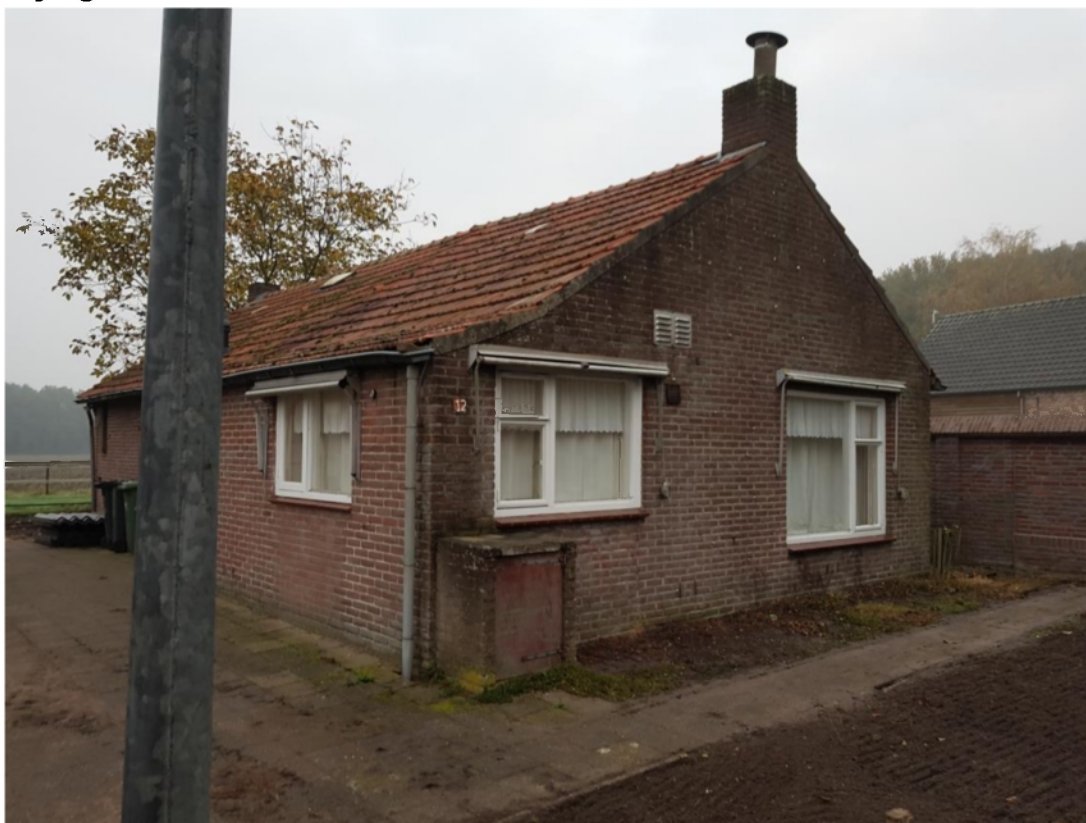
Voor/zijaanzicht te slopen woonhuis
