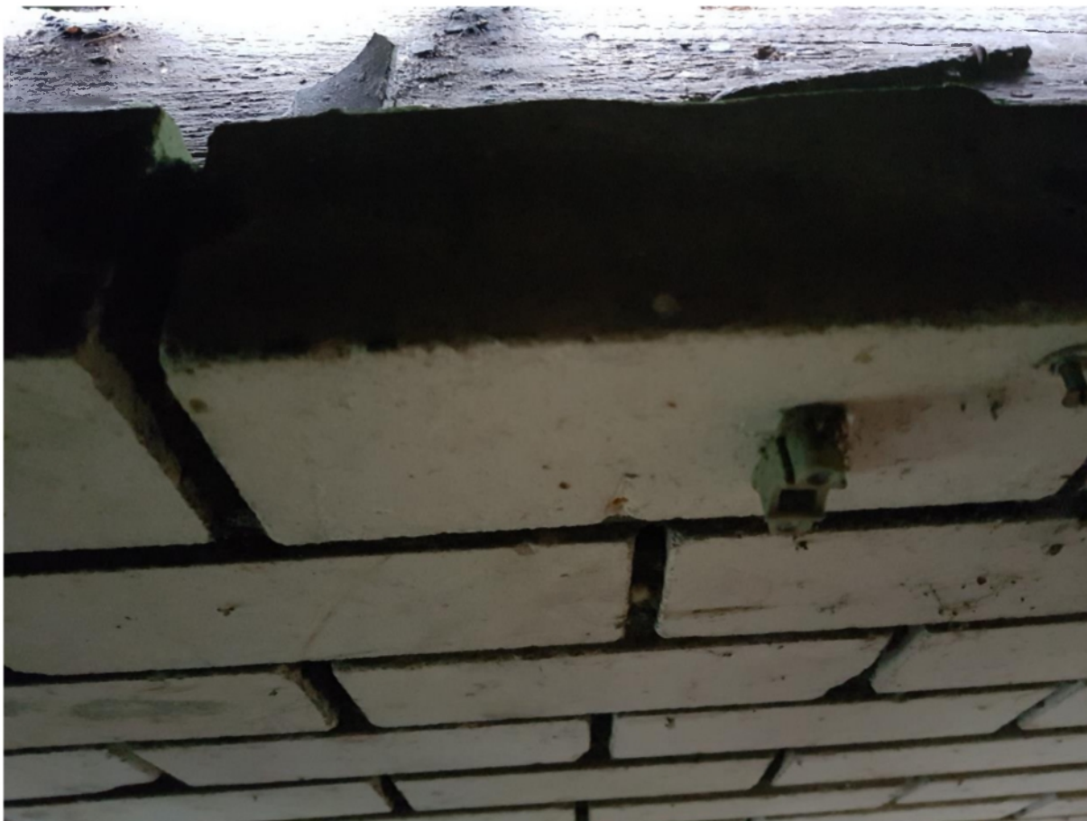
Halfsteense muur met opening naar buiten tussen dak en muur
