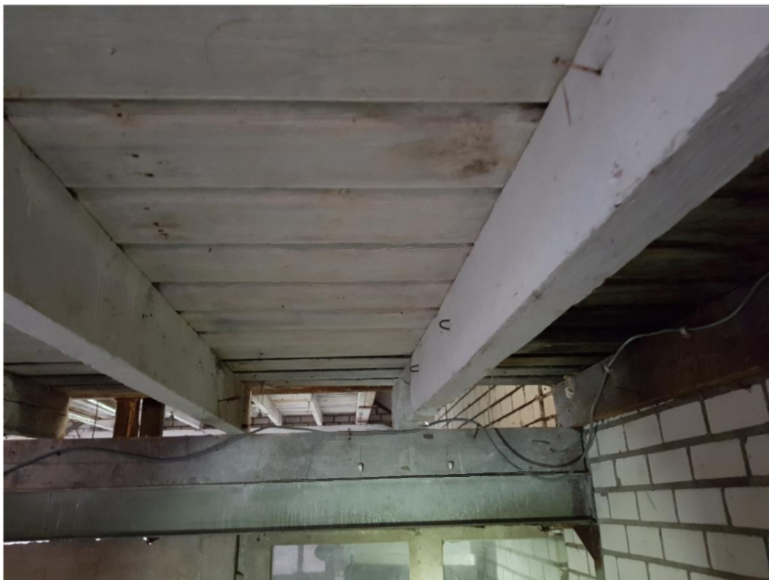
Binnenkant bijgebouw met vloer zolder
