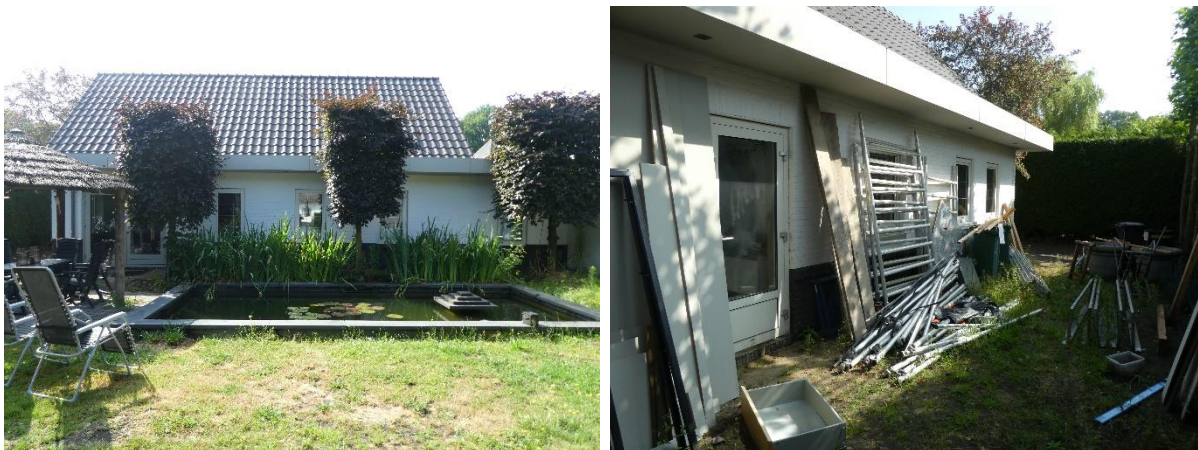
Afbeelding 7 en 8: Bestaande te verbouwen bebouwing. Bron: BNL advies. Datum: 23-06-2023
