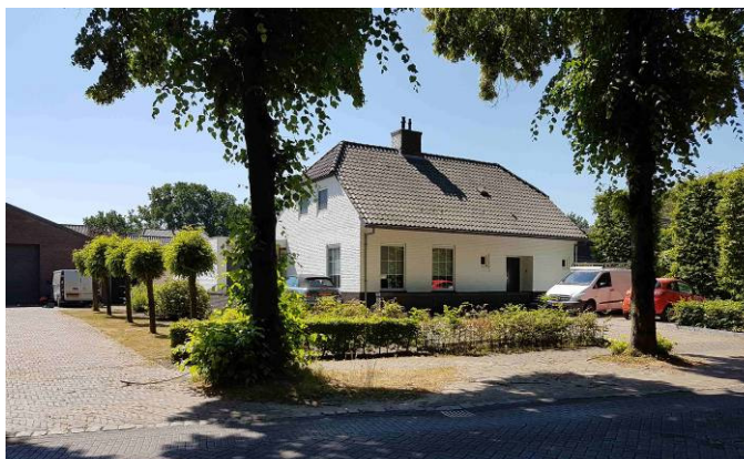
Foto 6: woning nr. 2d (vanaf noordzijde)
