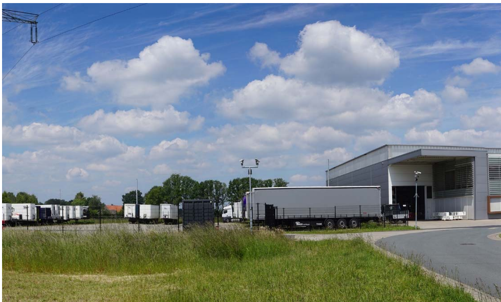
Plangebied met geheel verhard parkeerterrein en de westzijde van de bestaande bebouwing, waar de uitbreiding van Canline voorzien is.
