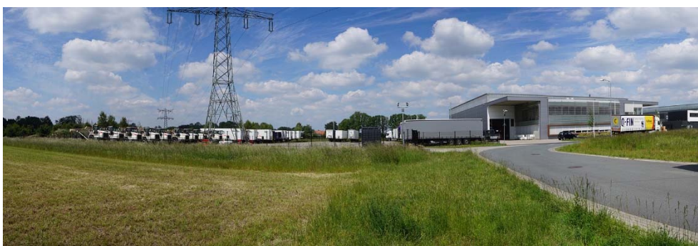
Rechts op de foto: het bestaande gebouw van Canline. Links daarvan het terreindeel waar uitbreiding gepland is.
