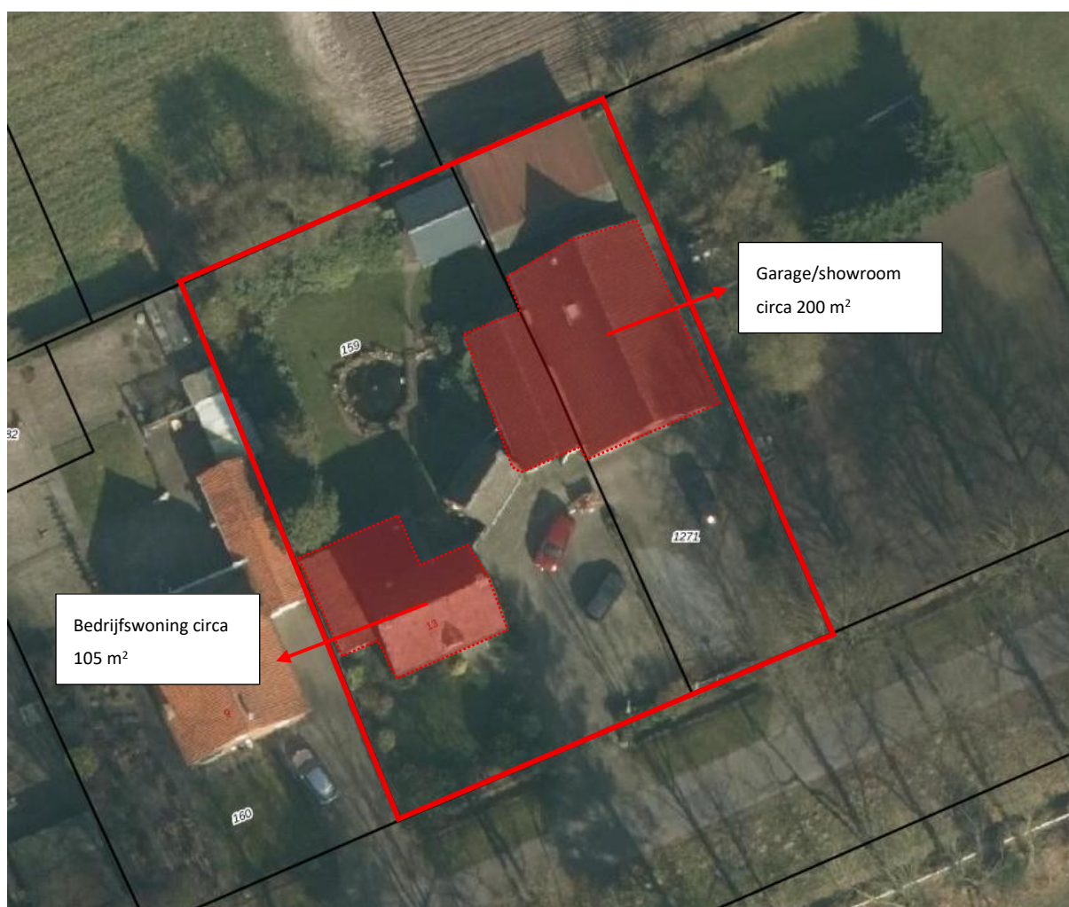
Figuur 3 Luchtfoto met duiding aanwezige bebouwing: bedrijfswoning en garage/showroom (planlocatie is indicatief voorzien van een rode omlijning)
