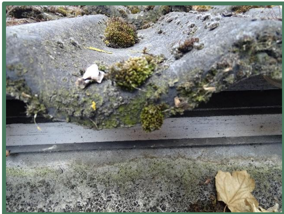
Foto 13: Achter de dakpannen dicht (tussengebouw).
