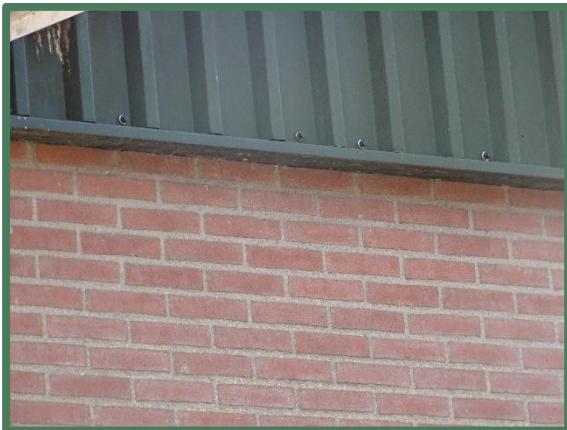
Foto 14: Dichte damwand rand (werktuigen berging)
