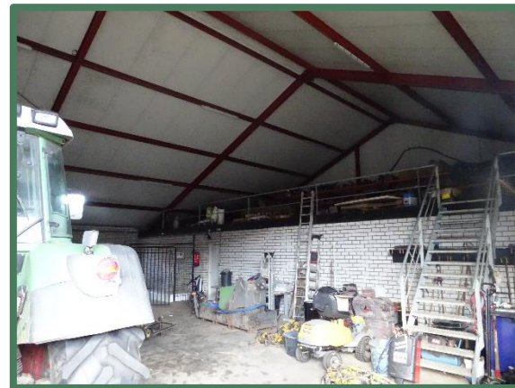
Foto 8: Overzicht binnenzijde loods bijgebouw.
