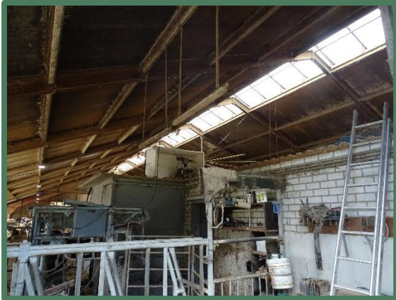
Foto 3: Overzicht binnenzijde koeienstal.
