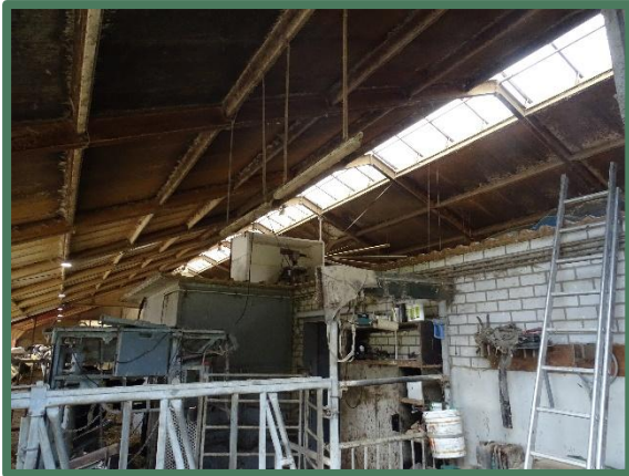
Foto 3: Overzicht binnenzijde koeienstal.
