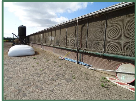
Foto 4: Overzicht terrein plangebied.
