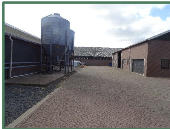
Foto 2: Overzicht terrein plangebied.
