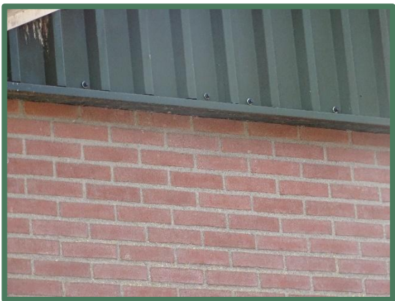
Foto 14: Dichte damwand rand (werktuigen berging)
