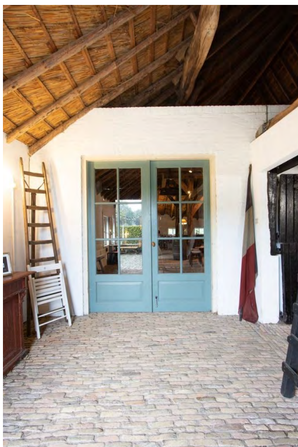
De scheidingsmuur dwars in de schuur, is in de brede middenbeuk voorzien van openslaande deuren, historiserend in vormgeving en daarbinnen maximaal transparant, waardoor het opbreken van de deel is verzacht. Rechts zicht vanuit de deel in de in de middenbeuk gebouwde garderobe en toiletruimten.
