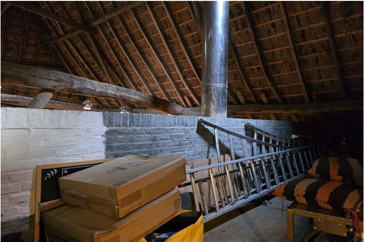
De scheidingsmuur is tot onder het niveau van de gebintplaten opgetrokken waardoor het nog steeds mogelijk is om een voorstelling te maken van de oorspronkelijke grootte van de tas/schuurruimte. De bakstenen zijn overduidelijk twintigste-eeuws. Het rookkanaal sluit aan op de open haard.
