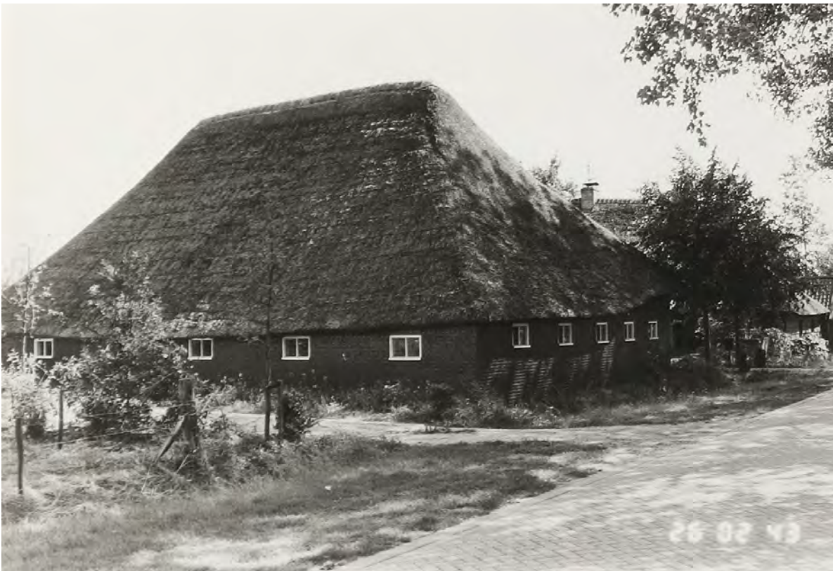
De schuur heeft een zestiende-eeuwse constructie en hoofdvorm. Gevels en wanden zijn van veel latere datum en hebben vensteropeningen gekregen die er oorspronkelijk niet zijn geweest. Op de foto zijn tussen de schuur en de boerderij twee vrij jonge Amerikaanse lindes te zien die inmiddels tot wasdom zijn gekomen. De schuuruitrit die er aan de straatzijde zal zijn geweest in het verleden, bestaat op de foto al niet meer.
