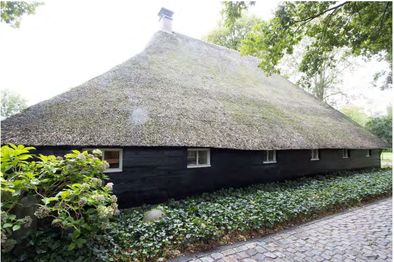
De lange noordgevel doorbroken met vensteropeningen.
