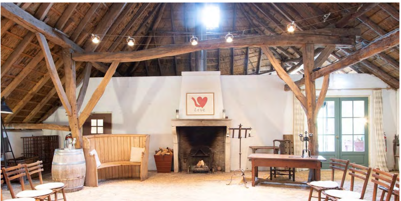
Het derde van de vier gebinten, gezien vanaf de zijde van de straat.
