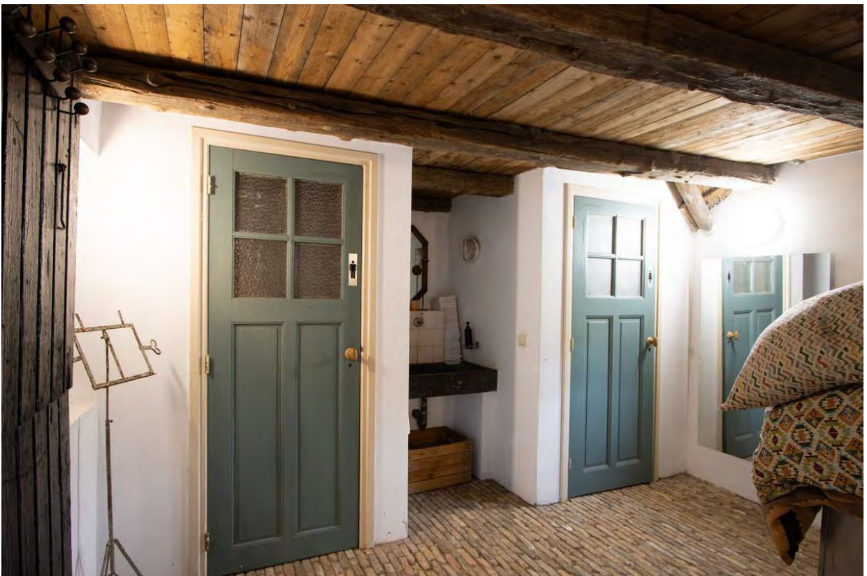
De toiletten en de zoldering met hergebruikte balken.
