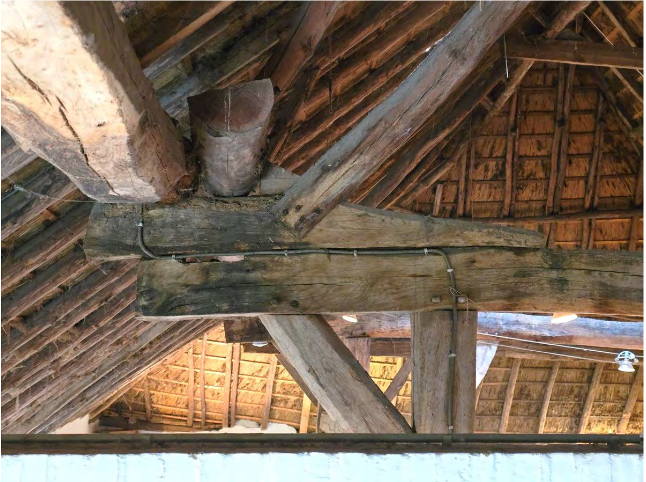
Detail van de secundaire klos tussen gebintbalk en gebintplaat. We zien hier ook dat het spantbeen gelipt is aan de klos, waaruit we op mogen maken dat spanten pas zijn geplaatst nadat de klos werd aangebracht. Kapspanten zijn vermoedelijk negentiende-eeuws.
