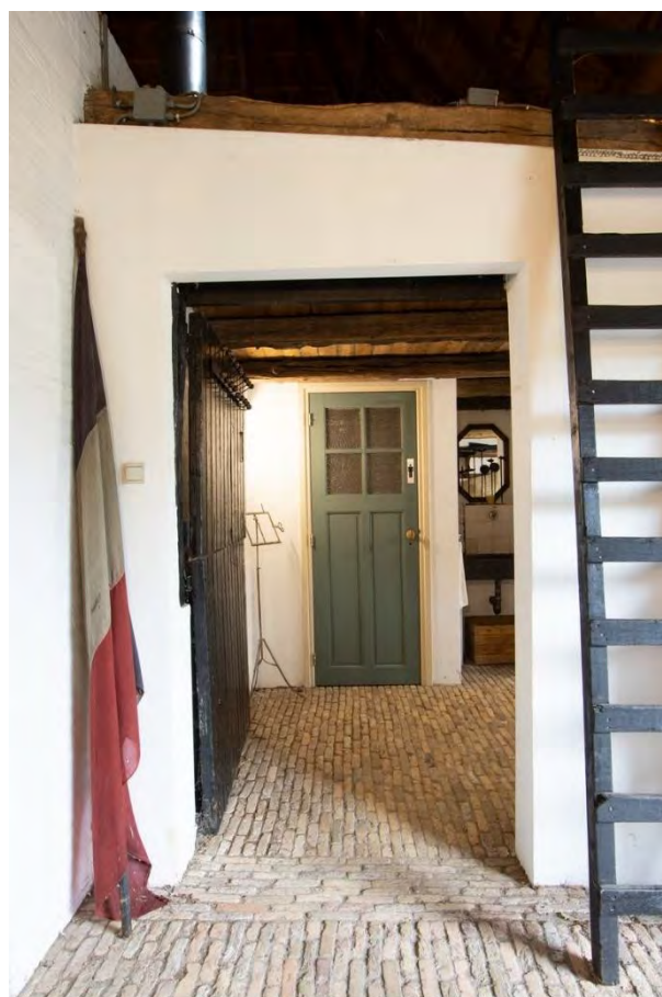
De scheidingsmuur dwars in de schuur, is in de brede middenbeuk voorzien van openslaande deuren, historiserend in vormgeving en daarbinnen maximaal transparant, waardoor het opbreken van de deel is verzacht. Rechts zicht vanuit de deel in de in de middenbeuk gebouwde garderobe en toiletruimten.
