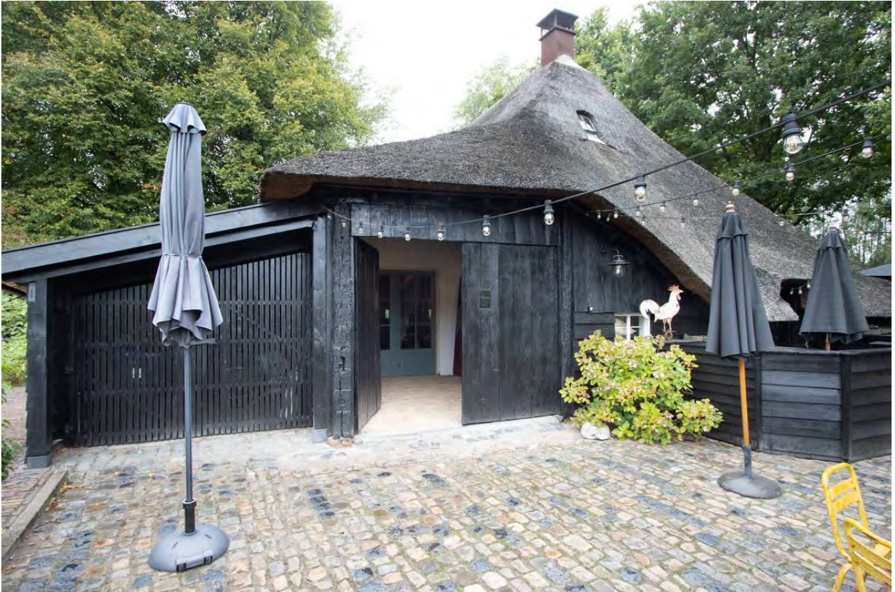
De op weide en akker gerichte gevel, met hoge inrit voor beladen karren. Typologisch detonerende aanbouw ter linkerzijde.
