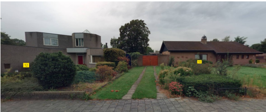
Afbeelding 10 - Streetview bestaande situatie Oude Baan 12 en 10
