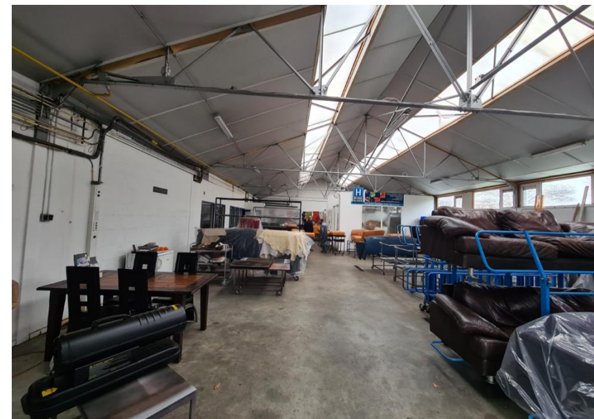
Figuur 9: Binnenkant bebouwing gezien vanuit de ingang in het oosten
