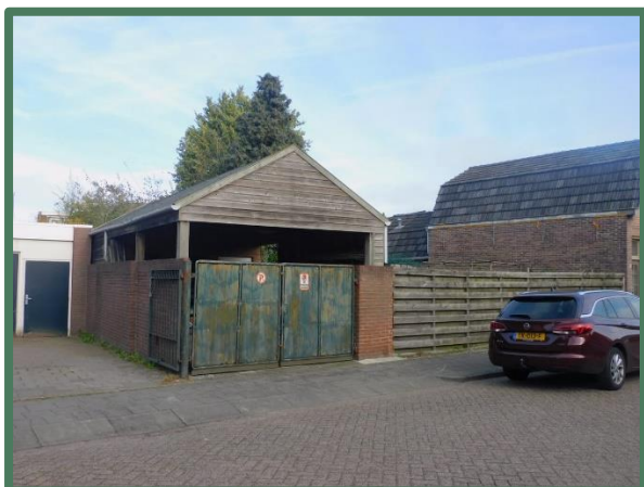
Te slopen garage buitenzijde
