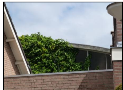
Figuur 8. Klimop langs westgevel van het te slopen pand op de onderzoekslocatie.
