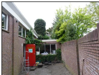
Figuur 7. Buitenplaatsje aan noordzijde, gezien in westelijk richting.
