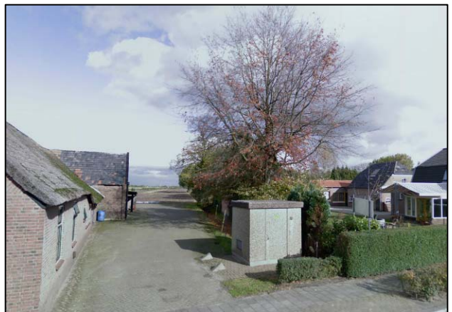
Aanzicht van het zij- en achtererf van de bedrijfsbebouwing
