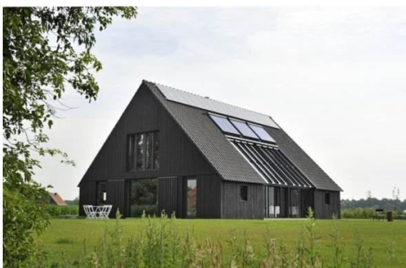
Enkelvoudige bouwmassa met een zadeldak evenwijdig aan de lange gevel
