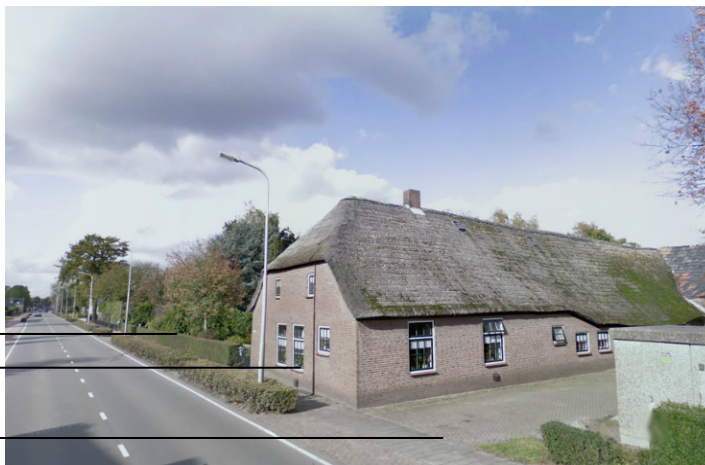
Bedrijfswoning aan de Eindsestraat
