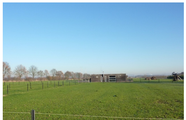
Bestaand gebouw 'belevingsruimte' kenmerkt zich door een laag silhouet met een afwerking in hout en een natuurlijk kleurgebruik
