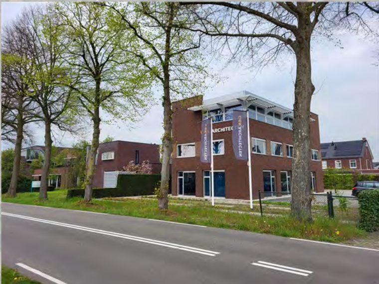
5 Kantoren Bolkensteeg 21a, 23, 25 (2 & 3 lagen met platdak)
