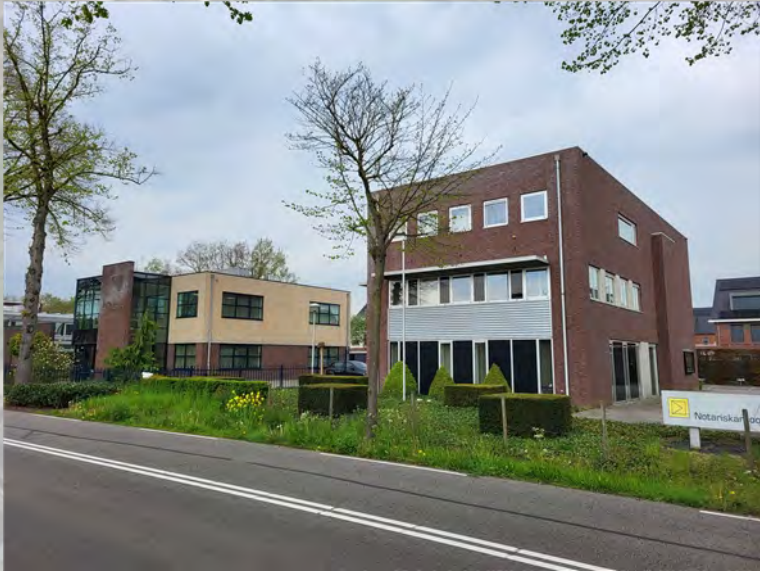
7 Kantoren Bolkensteeg 17a, 19 (2 & 3 lagen met platdak)
