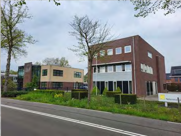
7 Kantoren Bolkensteeg 17a, 19 (2 & 3 lagen met platdak)
