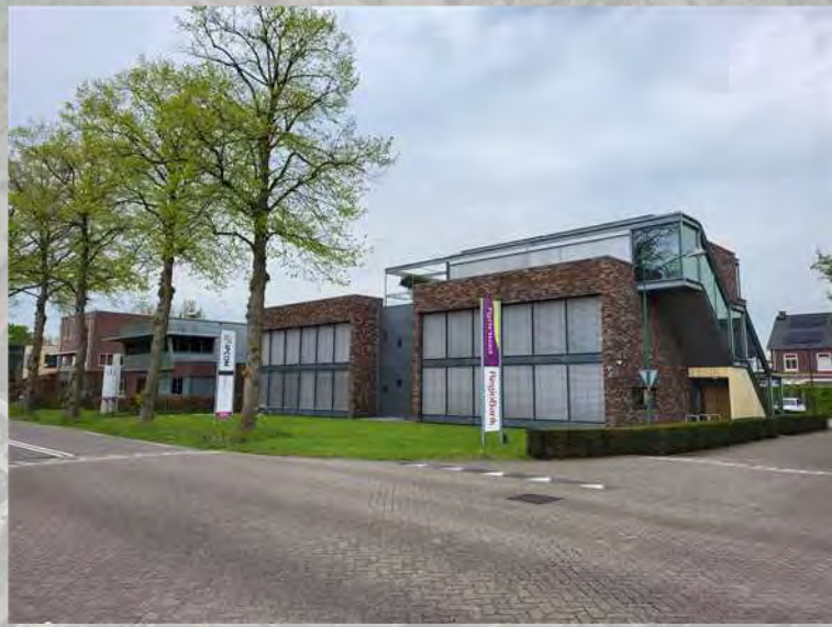
6 Kantoorgebouw Bolkensteeg 21 (3 lagen met platdak, setback)
