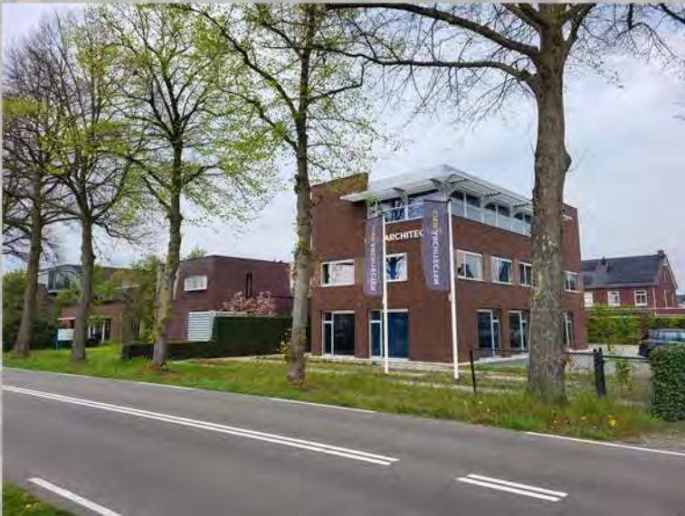
5 Kantoren Bolkensteeg 21a, 23, 25 (2 & 3 lagen met platdak)
