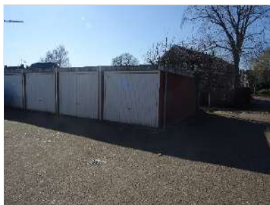
Figuur 2.5 Zuidwestzijde onderzoekslocatie.
