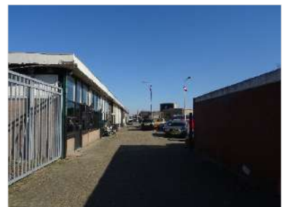
Figuur 2.7 Zuidwestzijde onderzoekslocatie.
