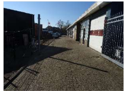
Figuur 2.4 Voorzijde gebouw
