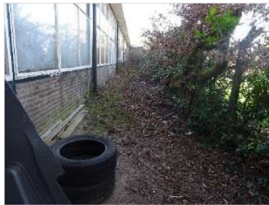
Figuur 2.3 Achterzijde gebouw.
