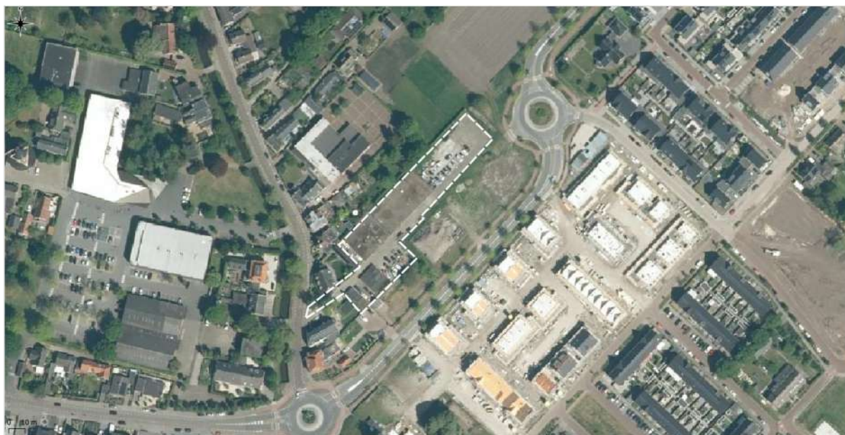
Figuur 2.1 Luchtfoto van de onderzoekslocatie.
