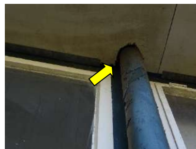
Figuur 5.5 Doorgang in boeiboord bij de regenpijp.
