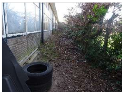
Figuur 2.4 Achterzijde gebouw.
