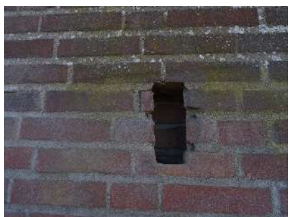
Figuur 5.6 Opening naar spouwmuur.
