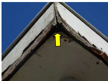
Figuur 5.3 Opening in boeiboord.
