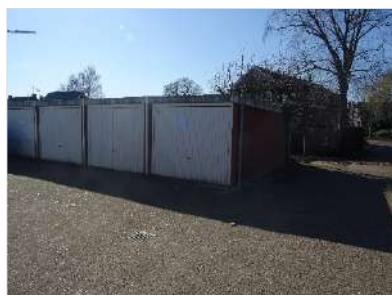
Figuur 2.6 Zuidwestzijde onderzoekslocatie.
