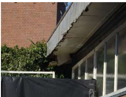
Figuur 5.4 Beschadigd boeiboord.
