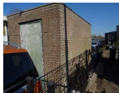
Figuur 5.8 Losstaand bakstenen gebouw.
