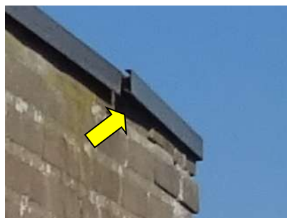
Figuur 5.7 Ruimte onder daklijst.
