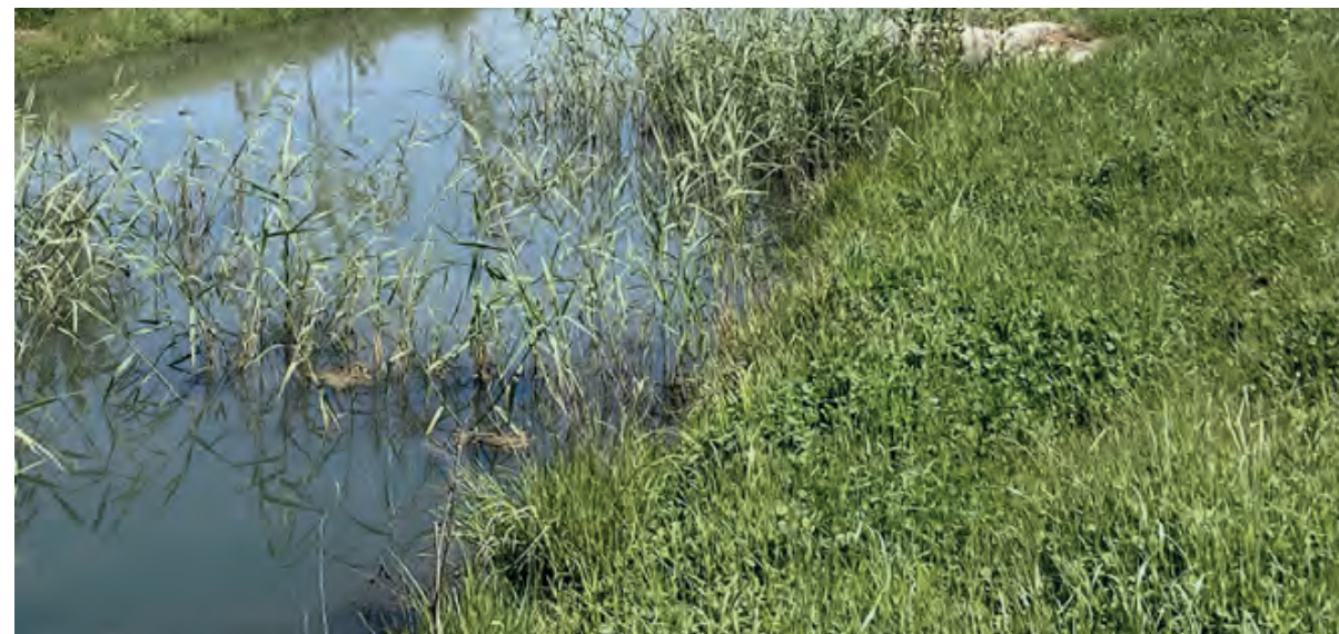
Wadi met flauw talud
