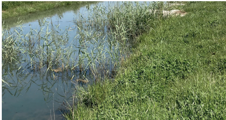
Wadi met flauw talud
