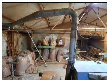
Figuur 8. Houtbewerkingsruimte in noordoostelijk gelegen schuur (momenteel in gebruik).
