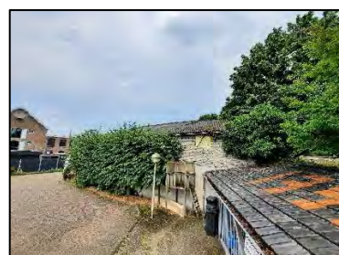
Figuur 13. Zicht op de aanbouw aan de zuidwestelijk gelegen schuur, rij met lindebomen en klimop op de zuidelijke gevel.
