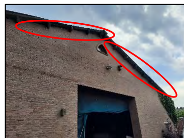
Figuur 10. Voorzijde zuidwestelijk gelegen schuur. In rood zijn de ruimtes tussen het dak en de gevel aangegeven.
