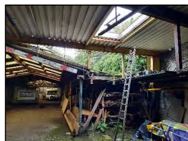
Figuur 7. Zicht op open gedeelte in de noordoostelijk gelegen schuur.
