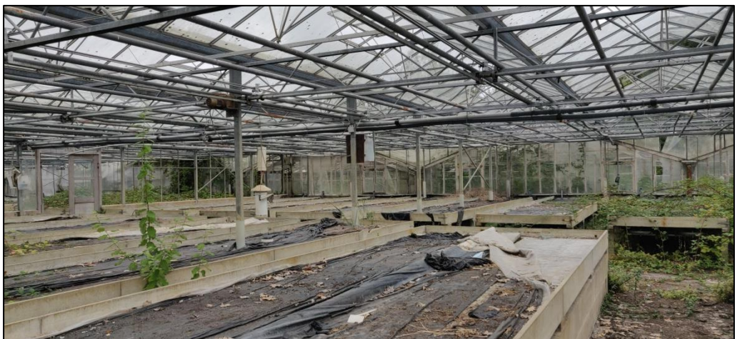
Binnenzijde zuidelijk kassencomplex
