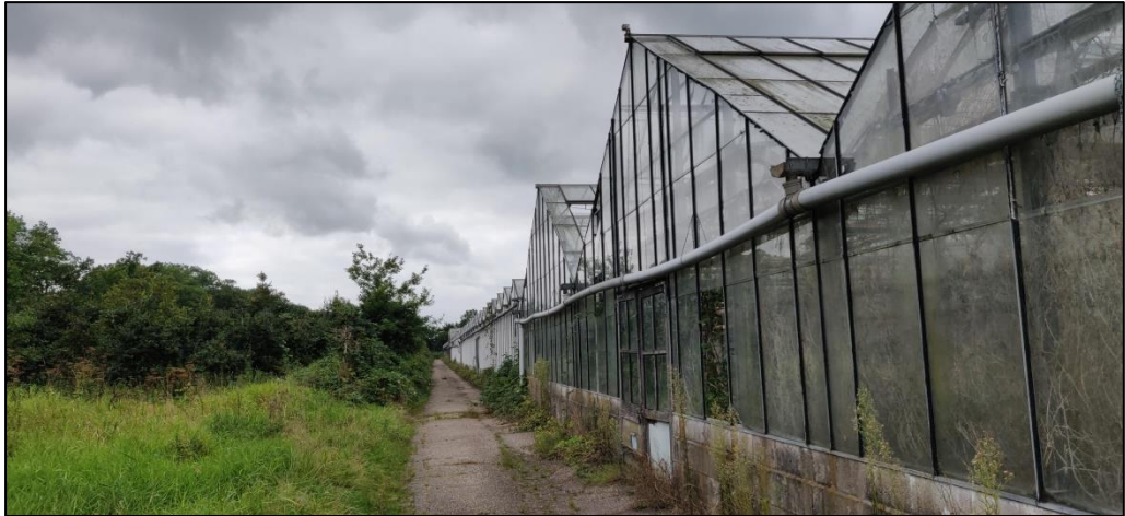
Rechts zuidelijk kassencomplex en links zuidelijke plantage
