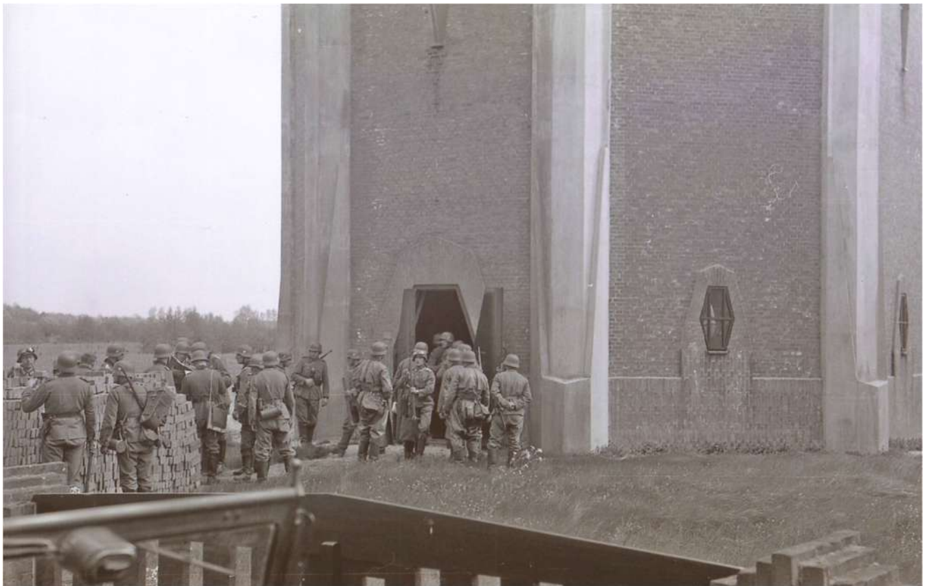
Fig.4 Duitse militairen hebben hier zojuist de deur van de watertoren open gebroken. Men heeft het gereedschap nog in de hand.
