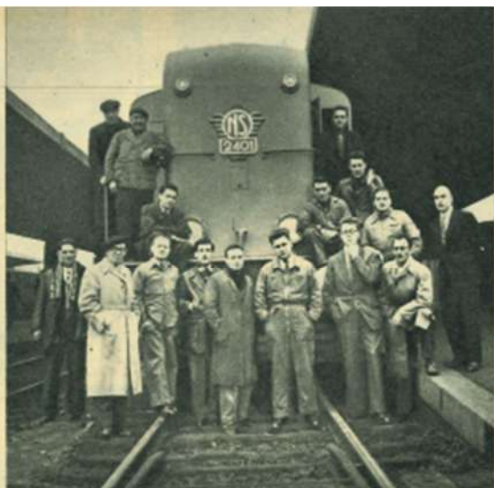
La 2401 et quelques-uns des techniciens de l'Alsthom et de la S.A.C.M., assistant aux essais.
