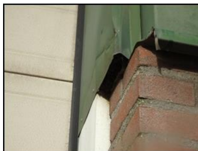
Figuur 22. Ruimte achter beplating, aanwezig aan de buitenkant van het gebouw direct ten westen van de onderzoekslocatie.
