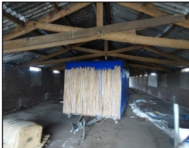
Figuur 9. Binnenzijde van schuur 2
