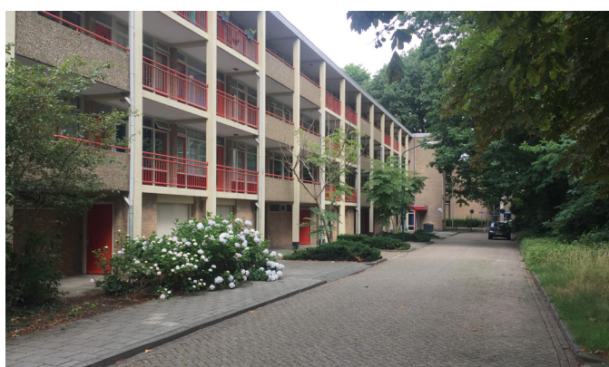
Figuur 2.9: Bestaand appartementencomplex aan de Dunantstraat
