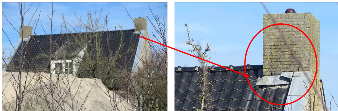
Figuur 3. Openingen in woonbebouwing aan de Danielsweg te Dongen waarin verblijfplaatsen kunnen zitten van vleermuizen en ook gierzwaluw zou er kunnen broeden.
