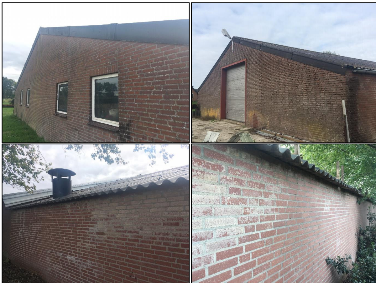
Afbeelding 16: Overzicht bebouwing aan de Oude Baan 133
