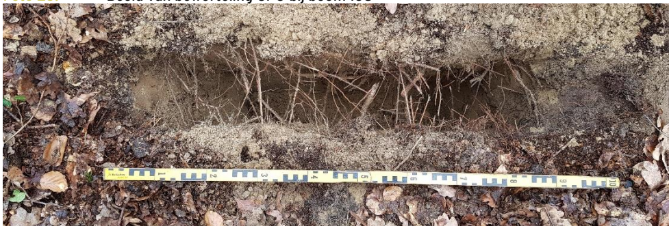
Foto 21. Boom op talud met blootliggende wortels door afgespoelde grond
