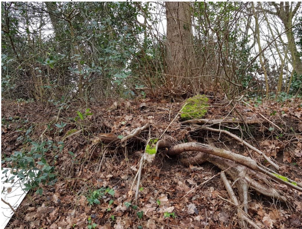
Foto 21. Boom op talud met blootliggende wortels door afgespoelde grond
