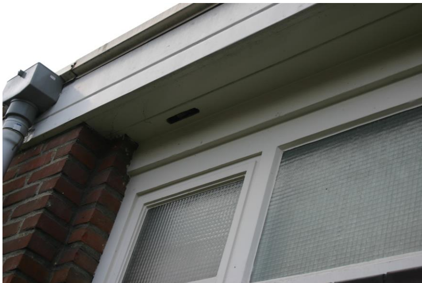
Figuur 4.2.4. Ventilatieopeningen onderzijde dakbetimmering.
