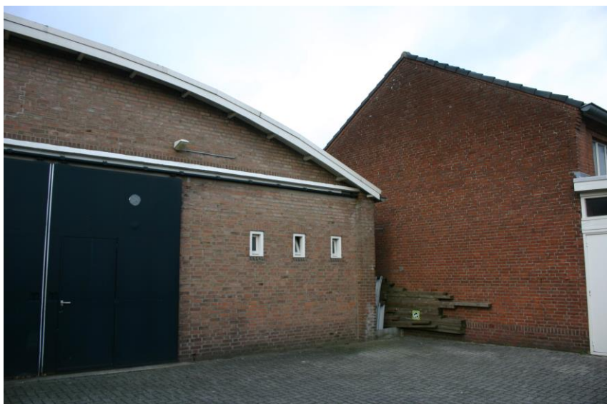
Figuur 4.2.1. Slechts één dakkant bevat overstekende gevelpannen (rechter gebouw).
