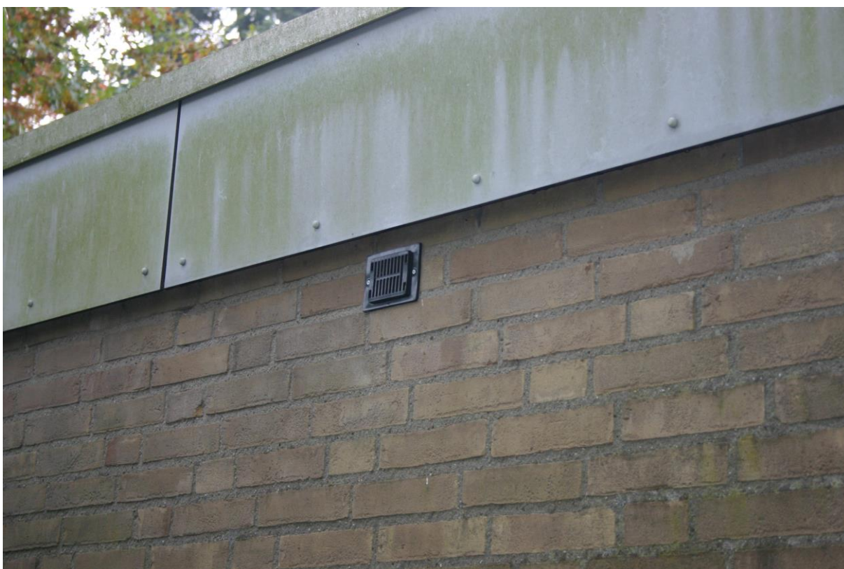
Figuur 5. De ventilatieopeningen zijn overal voorzien van roosters.
