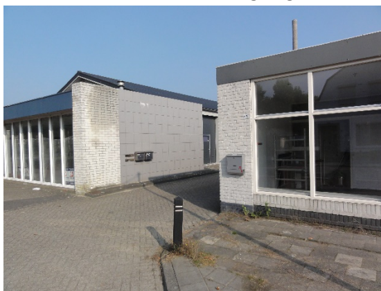
voorkant van het perceel met te slopen bedrijfspand
