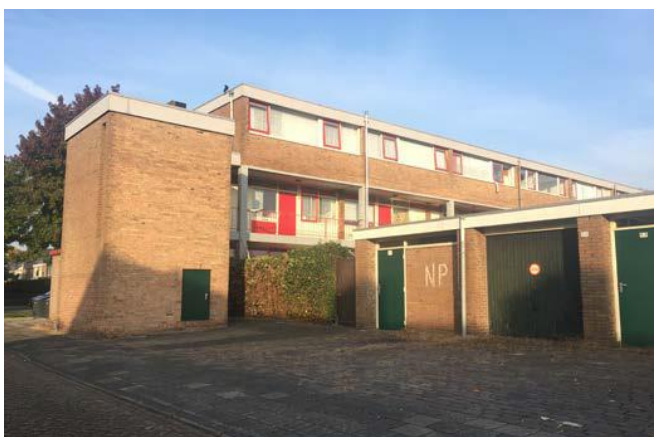
Achterzijde van appartementencomplex met garageboxen
