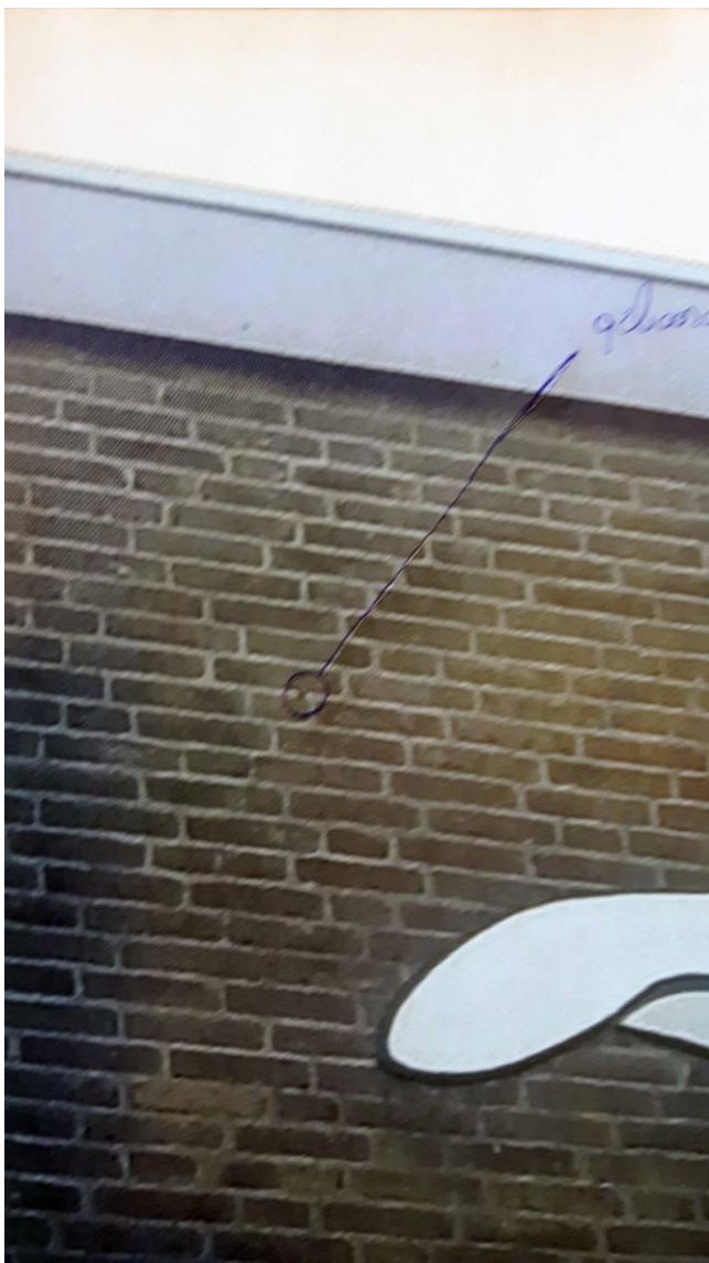
Figuur 5. Locatie waar één van de open stootvoegen is geboord (in complex 2018).
