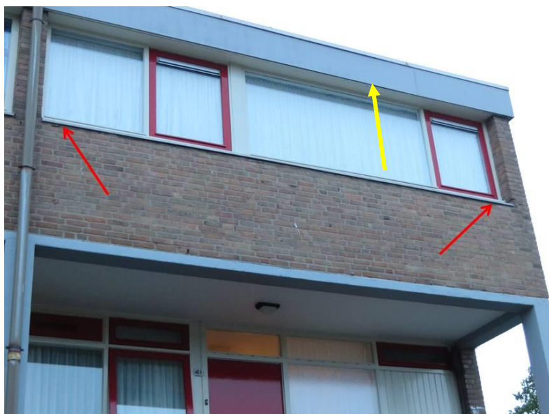
Figuur 2. Uitvliegopeningen zomerverblijf gewone dwergvleermuis (rode pijlen en gele pijl).
