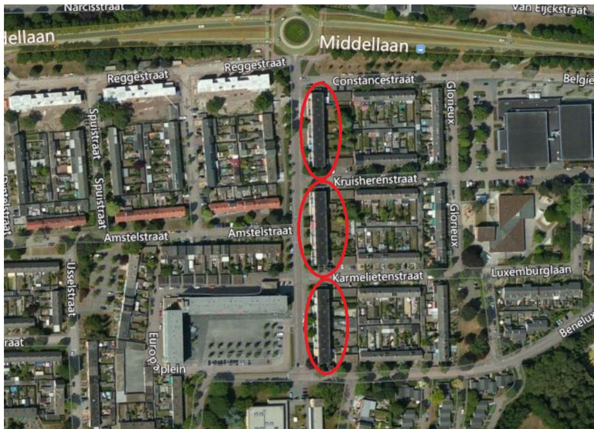
Figuur 1. De te renoveren woningen (rood omlijnd).
