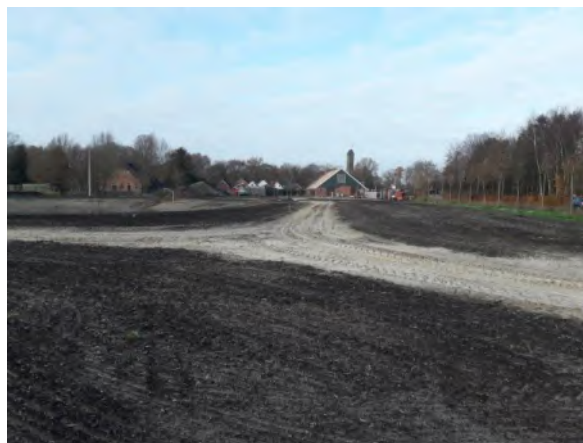
Foto 2: Paden zijn reeds aangelegd
