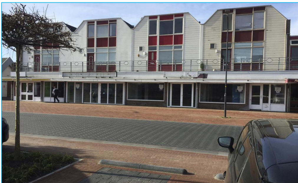
Fig. 1.1: Een weergave van de inmiddels gesloopte bebouwing
