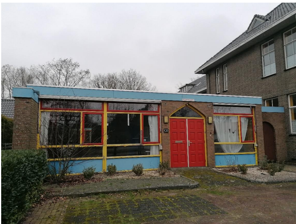
Foto 6. Aanbouw aan de linkerzijde van het Raadshuis. Aan de voorzijde zijn bakstenen delen te zien. Hierachter is het gebouw opgetrokken uit hout.
