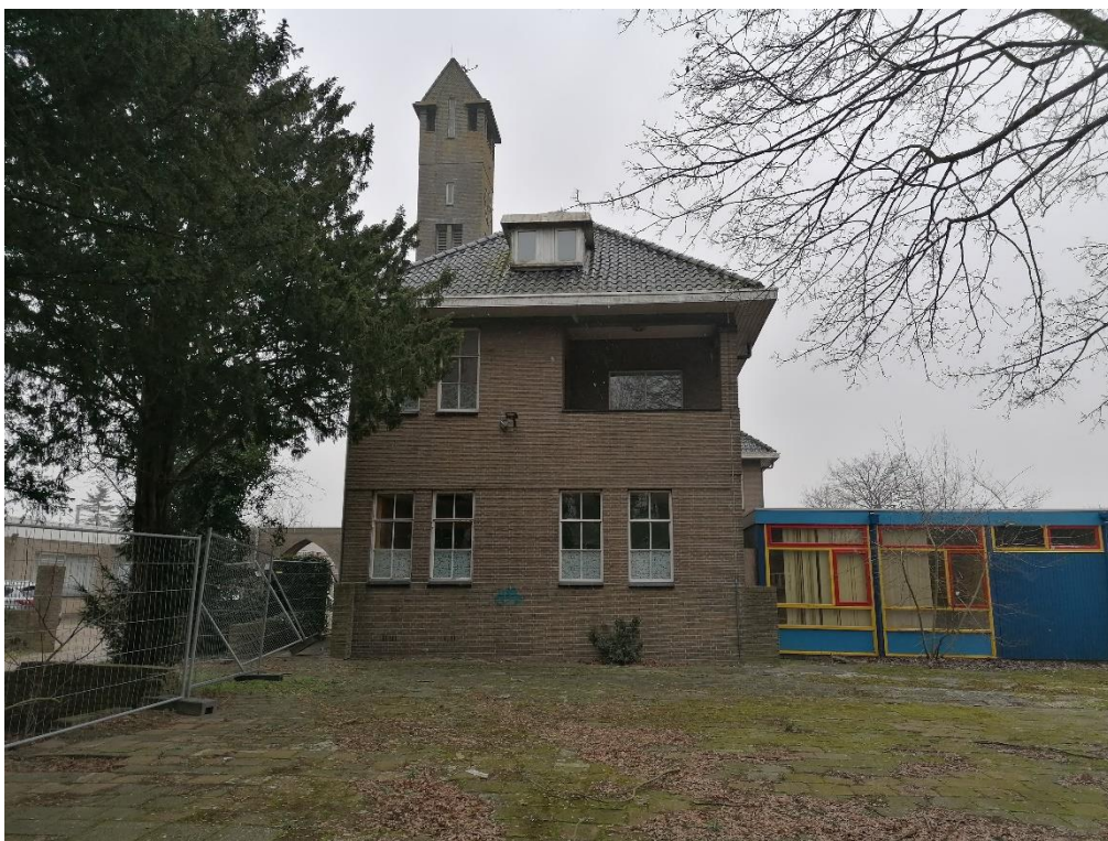
Foto 4. Achterzijde van het Raadshuis met aan de rechterzijde de aanbouw.
