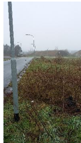
Fotonummer: 10 Omschrijving: Loop aan te leggen nieuwe leidingsectie in open ontgraving richting zuidwesten.
