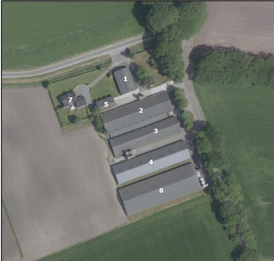
Afbeelding 3 Luchtfoto huidige situatie plangebied
