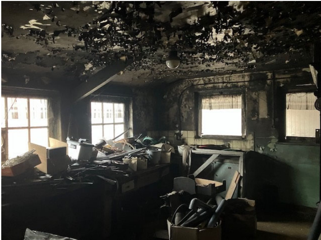
• Afbeelding 33: Werkplaats met veel rookschade door een slecht functionerende kachel
