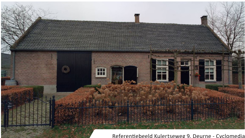
Referentiebeeld Kulertseweg 9, Deurne - Cyclomedia
