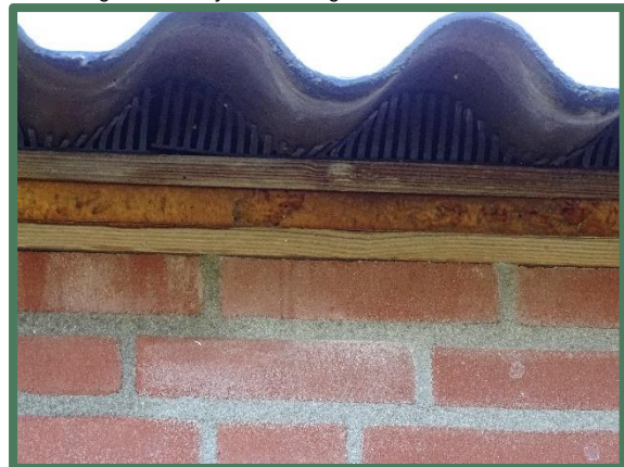
Foto 22 & 23: Openingen onder dak gedicht met cement of vergelijkbaar materiaal en vogelschroot met muurplaten.
