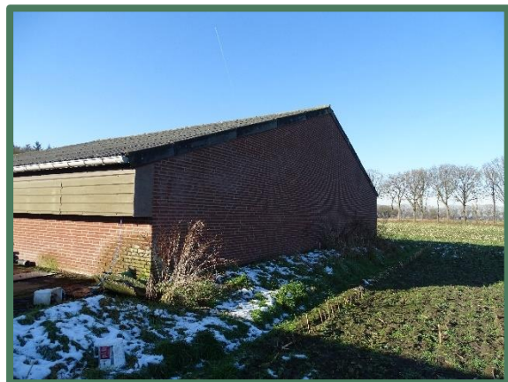
Foto 12: Noordoostzijde tweede bedrijfsgebouw.
