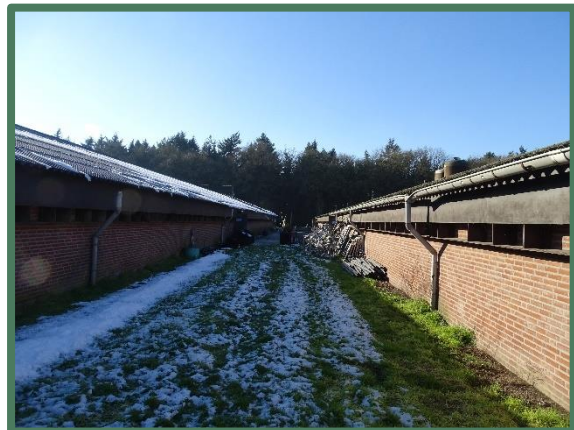
Foto 10: Noordwestzijde eerste bedrijfsgebouw (links) en zuidoostzijde tweede gebouw (rechts).
