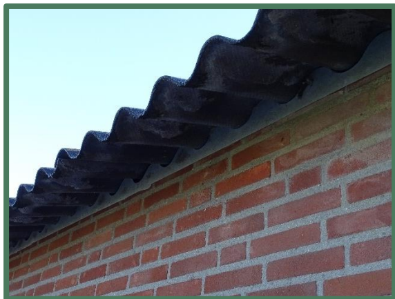
Foto 24: Openingen onder dak gedicht met metalen platen.
