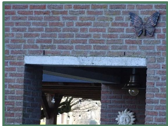
Foto 27 & 28: Open stootvoegen in de garage (links) en bedrijfswoning (rechts) die behouden blijven.
