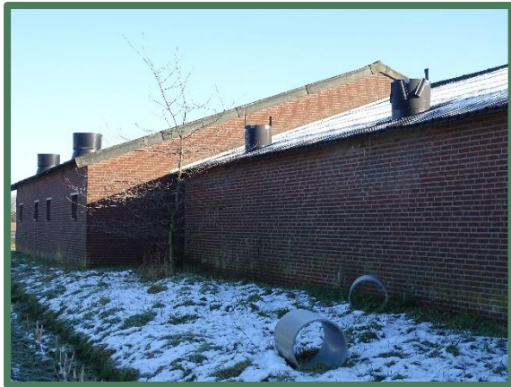
Foto 13: Noordwestzijde tweede bedrijfsgebouw, aanbouw.
