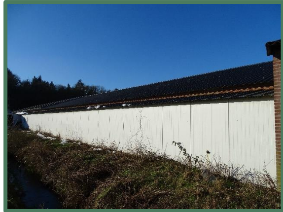
Foto 8: Zuidoostzijde eerste bedrijfsgebouw.
