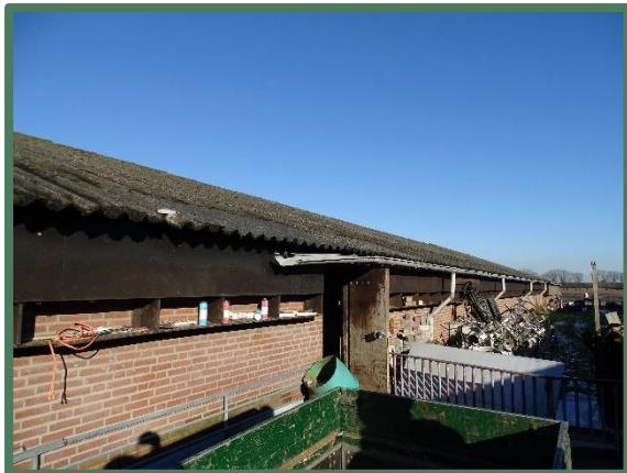
Foto 15: Zuidoostzijde tweede bedrijfsgebouw.
