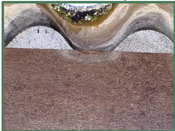
Foto 22 & 23: Openingen onder dak gedicht met cement of vergelijkbaar materiaal en vogelschroot met muurplaten.
