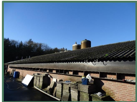
Foto 16: Zuidoostzijde tweede bedrijfsgebouw.
