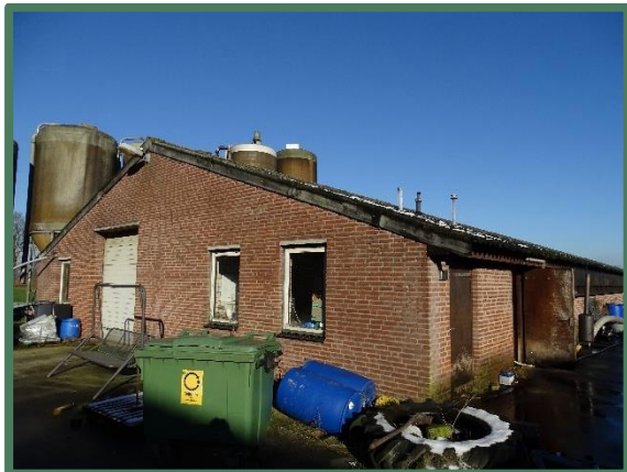
Foto 17: Zuidwestzijde tweede bedrijfsgebouw.
