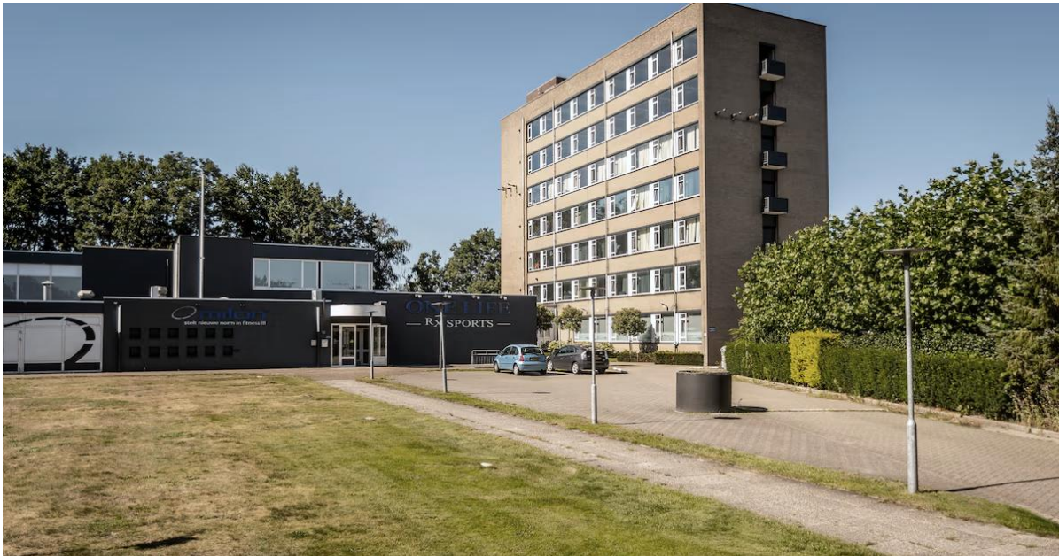
Figuur 6 Sportcentrum en zusterflat
