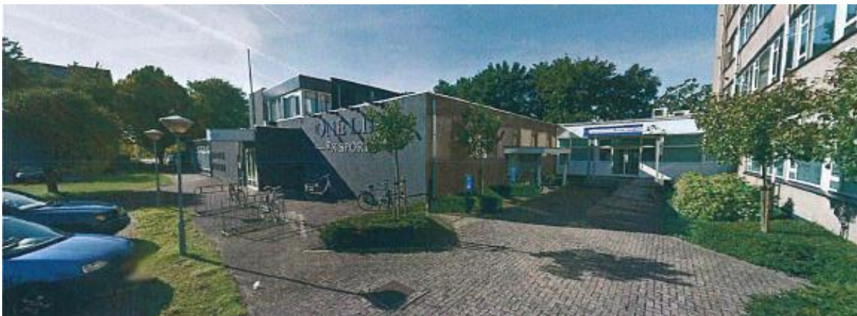
Figuur 8 Sportcentrum en zusterflat
